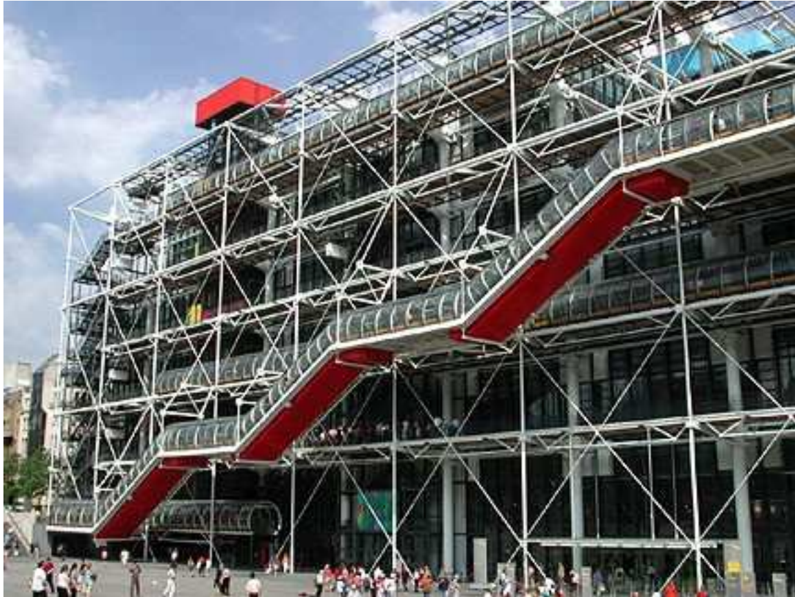
Parvis du bâtiment
