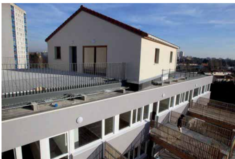
Vue du chantier en cours de réalisation
