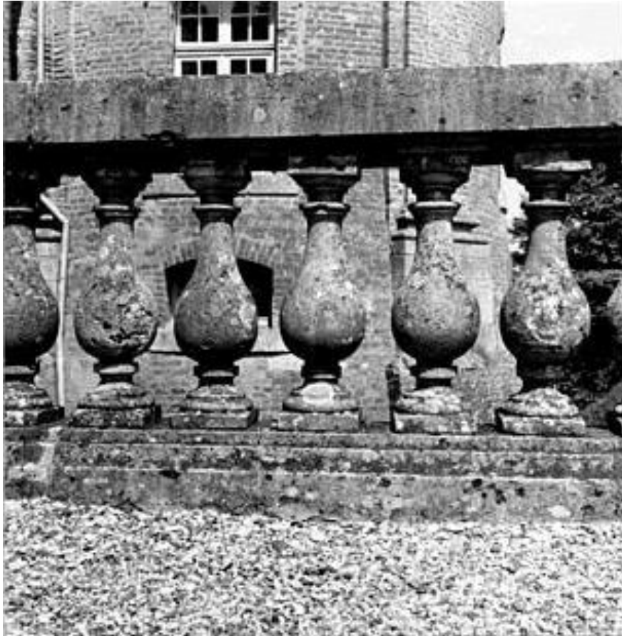
Rampe d'accès centrale de la balustrade en pierre de la façade est, château de Brossia, Neublans (Jura), France, XVIII e siècle
